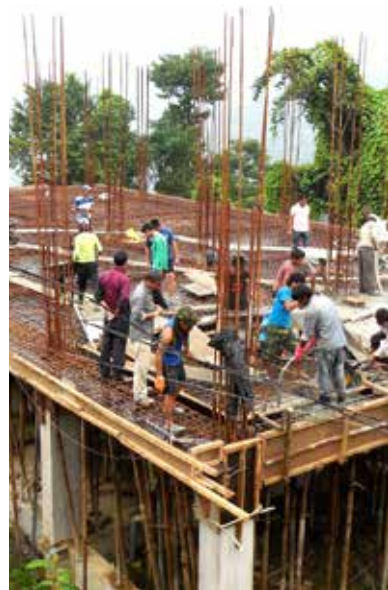
Nytt sykehus bygges.
