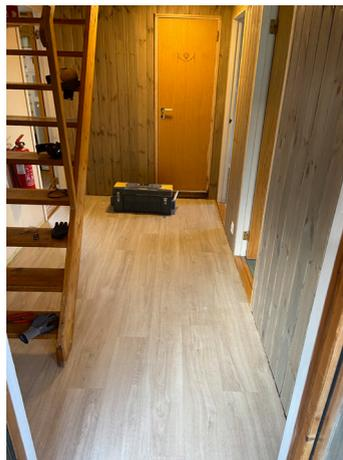
Arbeidet på hytte 5 er så godt som i hamn. Nytt bad, nytt kjøkken, nytt golv i gangar og på soverom, nye veggjar og tak i gangen, og ny ytterdør på vaskerommet. I tillegg er det rydda opp i det elektriske i gangen, og nytt sikringsskap med automatsikringer har kome opp. Dette er eit realløft!
