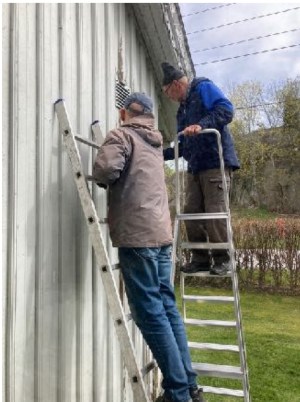
Arbeidet er i gang. Har du mulighet til å være med?
