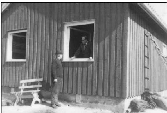
Fritz Helgor (i vinduskarmen) i samtale med Åsmund Berg. Hyttene er i ferdig med å bli ferdige. Våren 1967.
