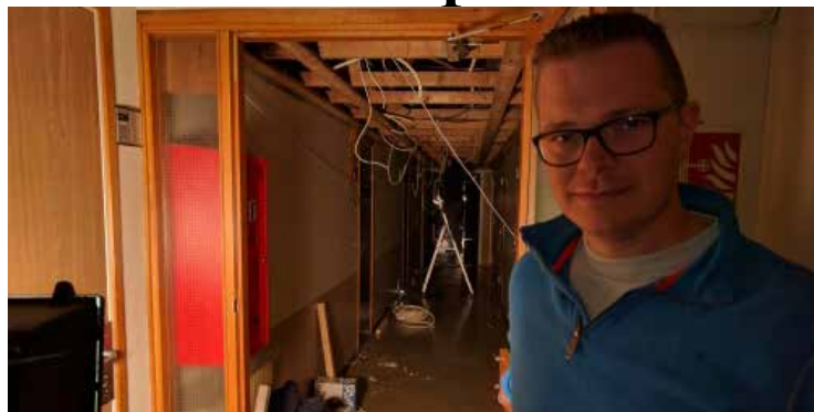
Ole Martin Syverstad ved inngangen til midtfløya som nå etterisoleres og brannsikres.
