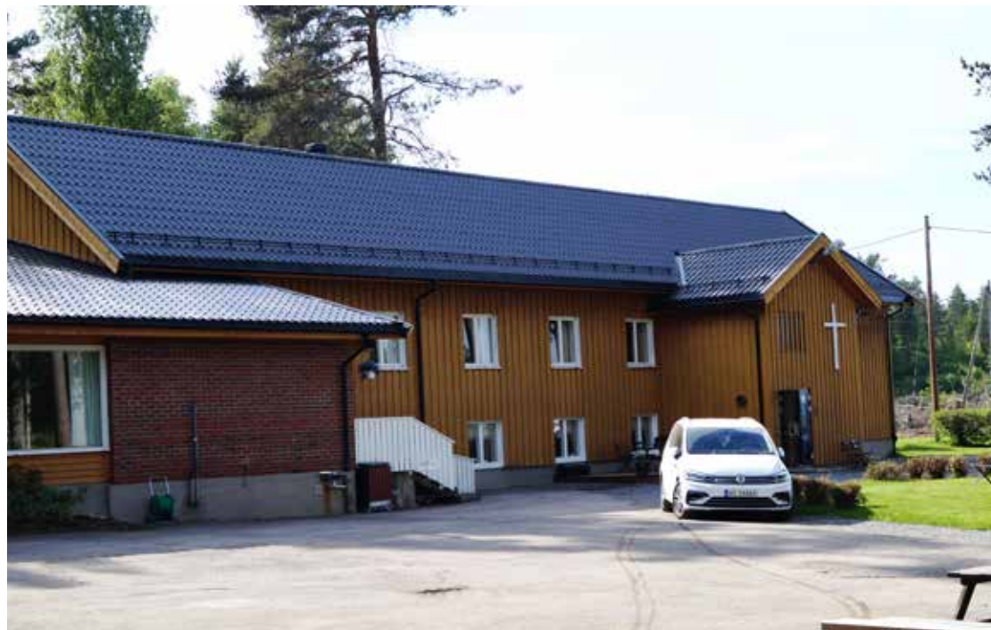
Sjøglimt har fått nytt tak, noe som har vært en stor investering, men som betyr mye. Foto: Åsmund Bjørnstad
